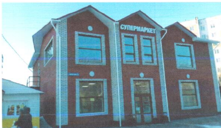
Фото 3. Фасад существующего здания магазина, подлежащего реконструкции
