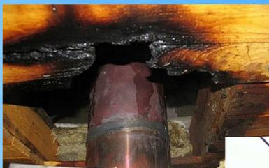
Соблюдать нормы противопожарной разделки (отступки) от горючих конструкций.
